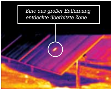
Simultane Inspektion mehrerer Solarmodule
