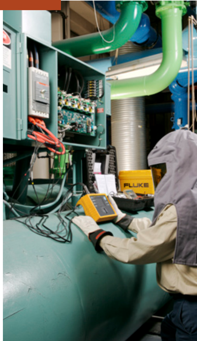
Mithilfe des Power Loggers Fluke 1735 kann die Leistungsaufnahme eines Kühlgeräts gemessen werden, um den Gerätewirkungsgrad festzustellen.
